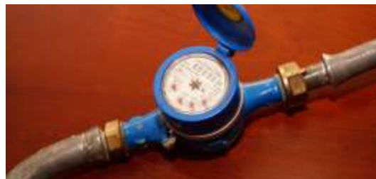
045: Contor de apă cu racorduri din țeavă din plumb - apometru pentru măsurarea cantităților de apă consumată, instalat pe rețea din țeavă de plumb
